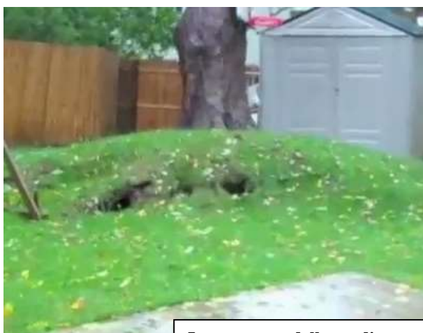
La sequenza dello sradicamento di un ippocastano posto in un giardino pensile sopra un'autorimessa (40cm di suolo)
